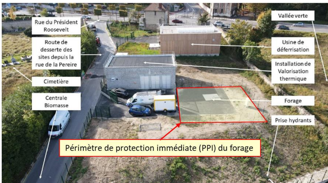
Figure 4. Photographie depuis la centrale biomasse des abords du PPI
