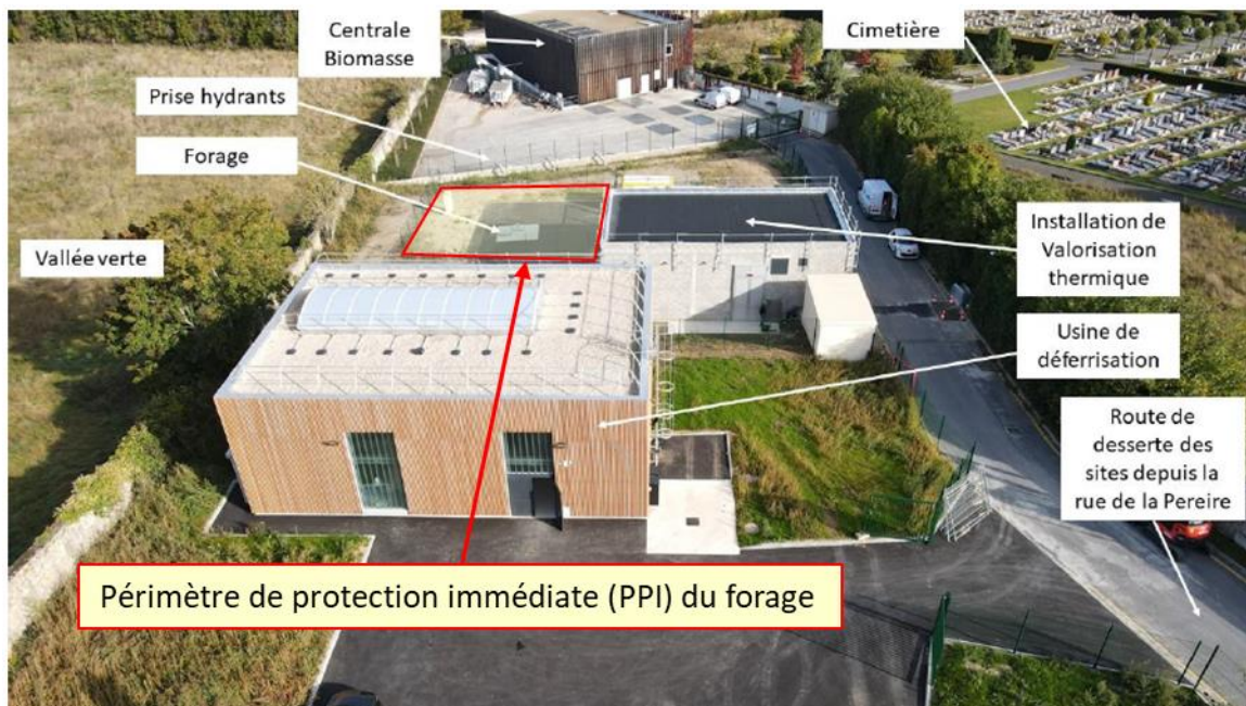
Figure 3. Photographie depuis la route nationale des abords du PPI
